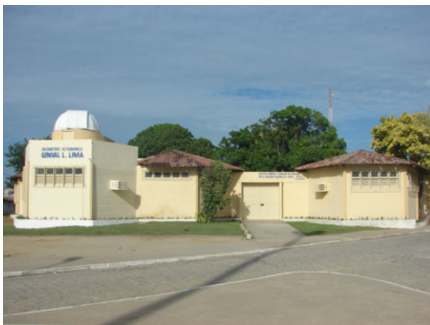
Figura 2. Centro de Ciências e Tecnologia da Educação e Observatório Genival Leite Lima
