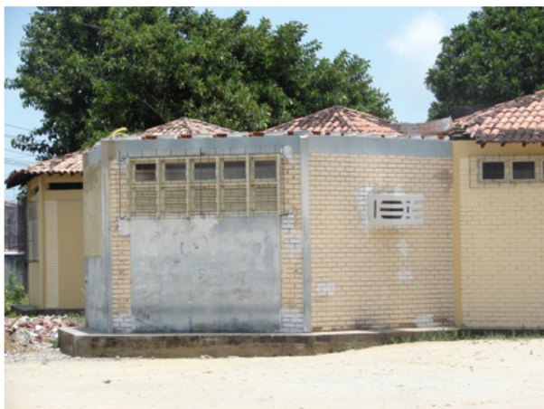
Figura 1. Início da construção em agosto de 2008
